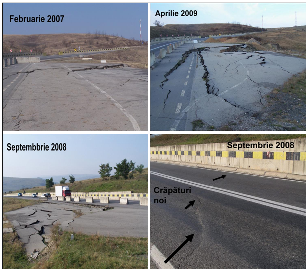
Fig. 126. Alunecare de teren recentă (2005-2006) care afectează drumul European E81
