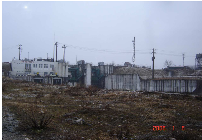
Fig. 9 Le barrage de l'accumulation Petrești
