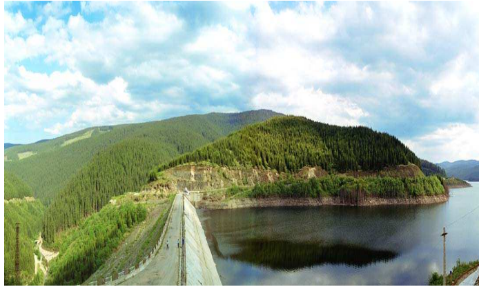
Fig. 6 Le barrage et l'accumulation Oașa
