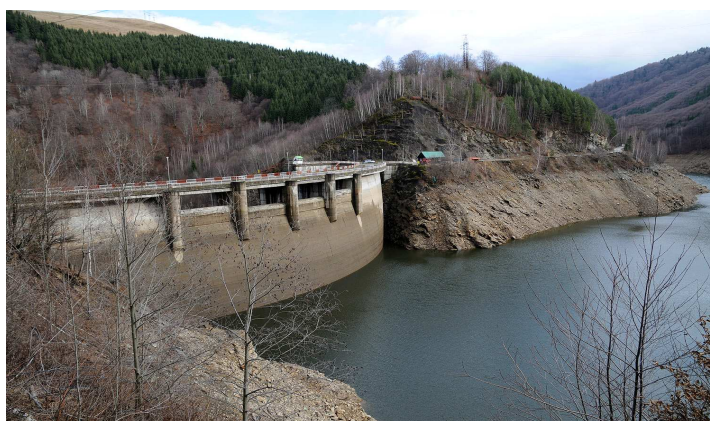
Fig. 7 Barajul și acumularea Tău
