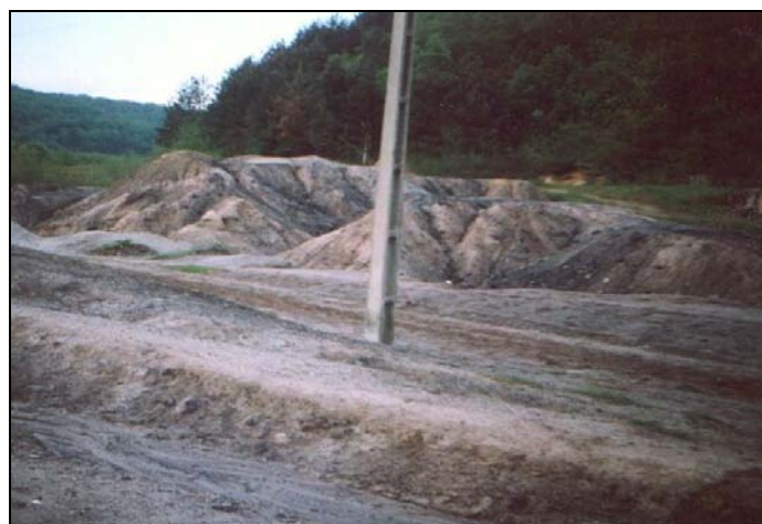
Figura 5. 33. Haldă de steril din cadrul perimetrului minier Teștioara, înainte de reconstrucție
