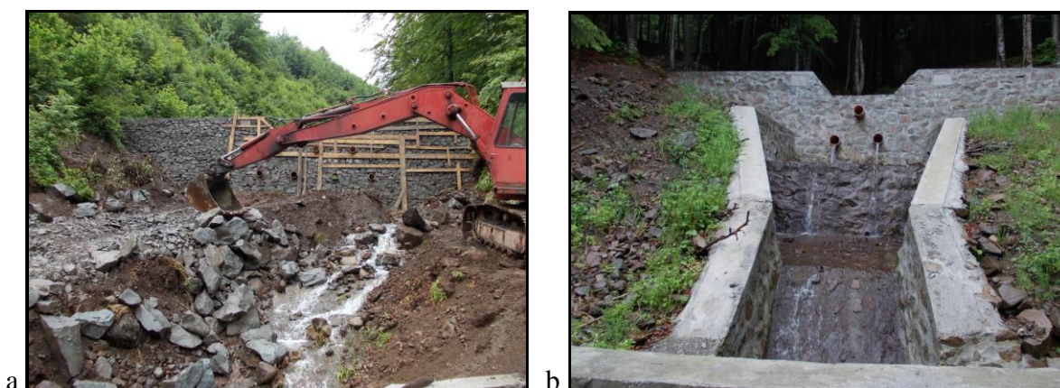
Foto 6. a și b. Lucrări de corectare a torenților în micro-bazinul Tireu (iunie 2011).
