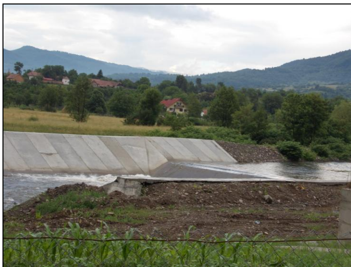
Foto 7. Lucrare de consolidare de maluri și regularizarea cursului râului Gurghiu, comuna Ibănești (iunie 2011).
