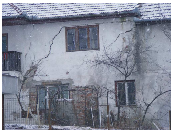
Fig. 8. Casă fisurată (str. Rosetti, 2008)
