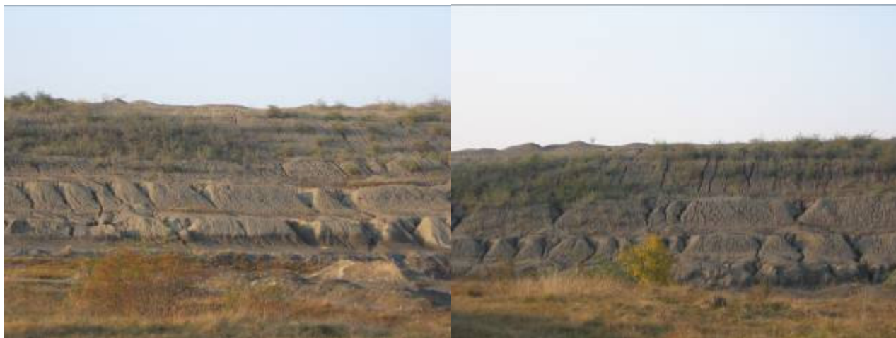
Fig. 26. Procese de versant pe taluzul iazului de decantare Băișoara (foto: autor, octombrie 2009)
