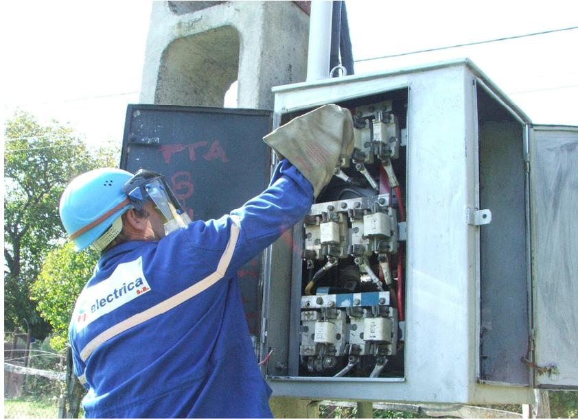
Fig. 5 Electricien travaillant à un poste de transformation, au niveau du sol
